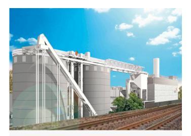
Die modernisierte Heizzentrale «Fernwärme Liestal» erhält zwei haushohe Holzschnitzelkessel mit Förderanlage, um die Holzschnitzel automatisiert zu transportieren.
