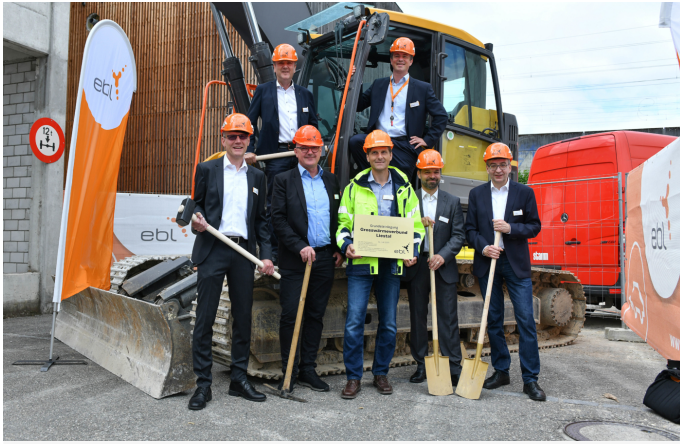
Grundsteinlegung zum Grosswärmeverbund Liestal v.l.n.r. Roger Scheidegger, Erich Geiser, Isaac Reber, Urs Gerhard, Tobias Andrist, Daniel Spinnler, Urs Saladin
