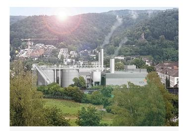
Mit der Fassade aus Betonelementen in Holzoptik und dem Lichtband im Dachbereich erfüllt die neue Heizzentrale die Anforderungen der Stadtbildkommission.
