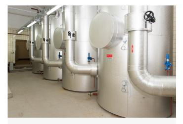
Dank Abwärmenutzung bei der Produktion kann die Brauerei Energie ins Netz des Wärmeverbunds Rheinfelden einspeisen. Über 600 Haushaltungen werden mit Abwärme aus der Bierproduktion für Warmwasser und Heizung versorgt.
