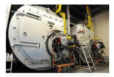
Mit Alkohol, der bei der Produktion von alkoholfreiem Bier als Nebenprodukt entsteht, heizt Feldschlösschen die Braukessel. Damit spart die Brauerei für die Produktion rund ein Viertel Gas und Öl.
