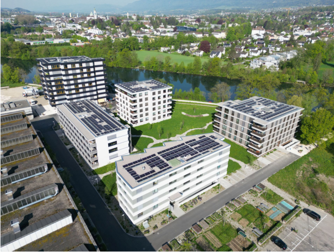
Riverside Zuchwil (2022): 140 nouveaux logements, 187 autres prévus. Le site 2000 watts produit plus d'électricité qu'il n'en consomme.
