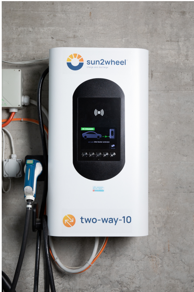
Bidirektionale Ladestation two-way-10 von sun2wheel im Betrieb.
