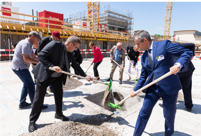
Die offizielle Grundsteinlegung von uptownBasel fand am 7. Juni 2019 statt.
